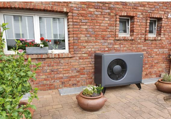
Diese gibt das Verhältnis von produzierter Wärme zu eingesetztem Strom wieder. Eine Arbeitszahl von 4 bedeutet, dass mit einer Kilowattstunde Strom 4 Kilowattstunden Wärme erzeugt werden können. Je geringer die benötigte Vorlauftemperatur, desto größer die Arbeitszahl und desto höher die Effizienz der Wärmepumpe.
