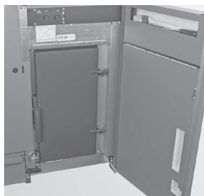
Fig. 5 Porte de revêtement ouverte
