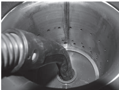
Fig. 62 Aspirer aussi les cendres du tube d'air primaire au milieu du creuset de brûleur
