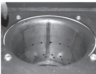
Fig. 61 Nettoyer les volets d'air secondaire dans le creuset du brûleur
