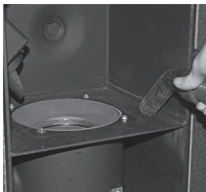
Fig. 53 Éliminer les résidus de combustion de la chambre de combustion
